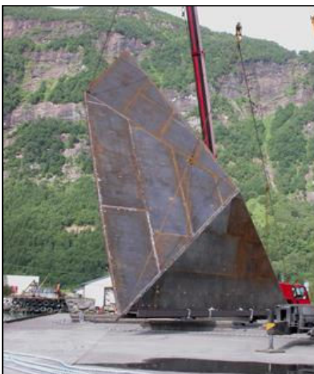
Figur 5.3. Bilder av fordelerplaten ved utsett i Gaupne.
